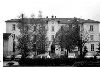
Bâtiment du Lycée Charpak
